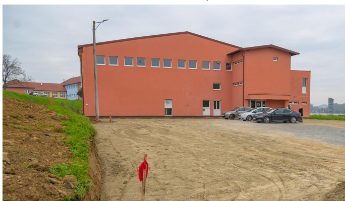
Parkiralište školsko-sportska dvoranja - gradnja
