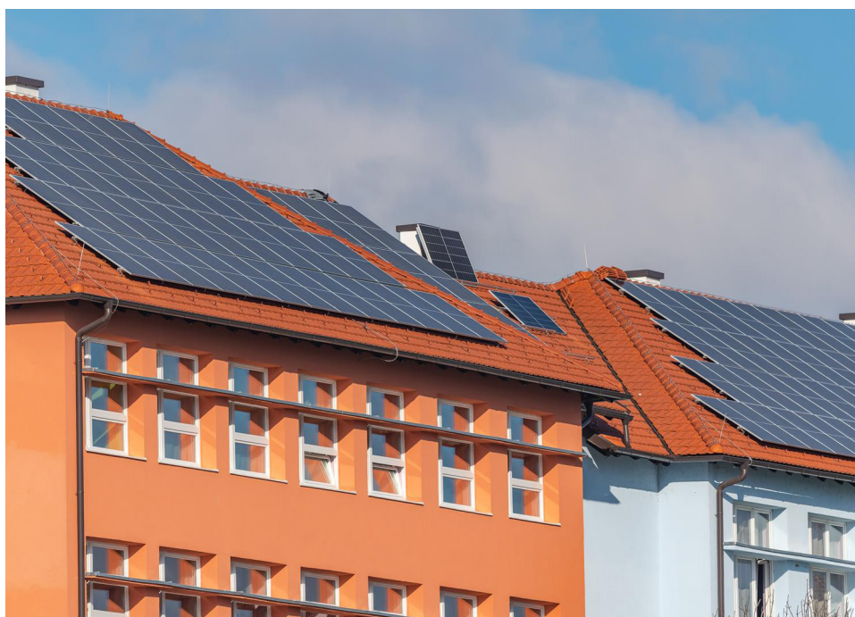
Postavljanje solarnih panela na OŠ Čazma
